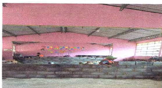
Foto 3: Así fue el proceso de cerramiento de dos banos en módulos de aulas
