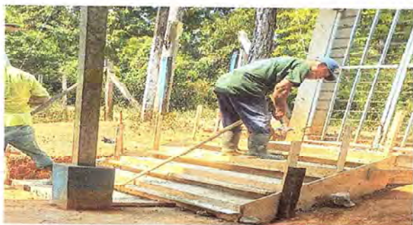
Foto1: proceso de gradas de concreto
