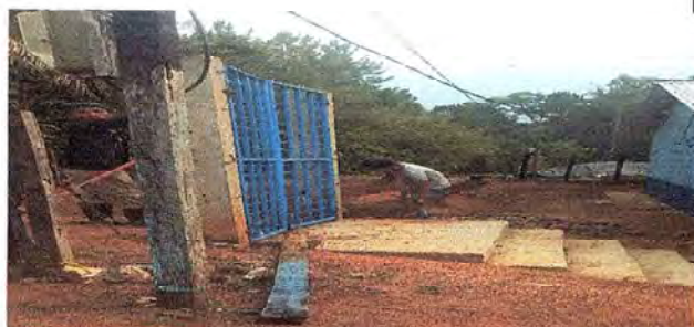
Foto 5: continuidad del muro perimetral
