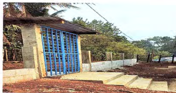
Foto 4: Muro perimetral frente a escuela
